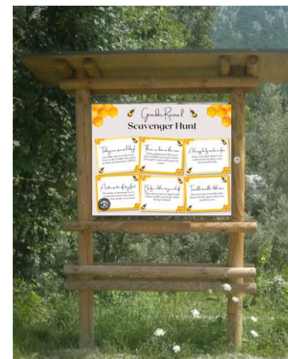
Percorso « Caccia al tesoro a tema api » Lunghezza=2800 m Installazione di bacheche bifacciali in legno con tabelle informative in alluminio serigrafato a colori e indovinelli, in misura di 1 ogni 200 m circa
