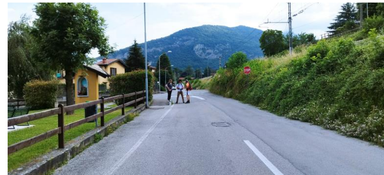
FOTO 1 - Impianto di videosorveglianza - Posa di bacheca informativa in legno con cartello
