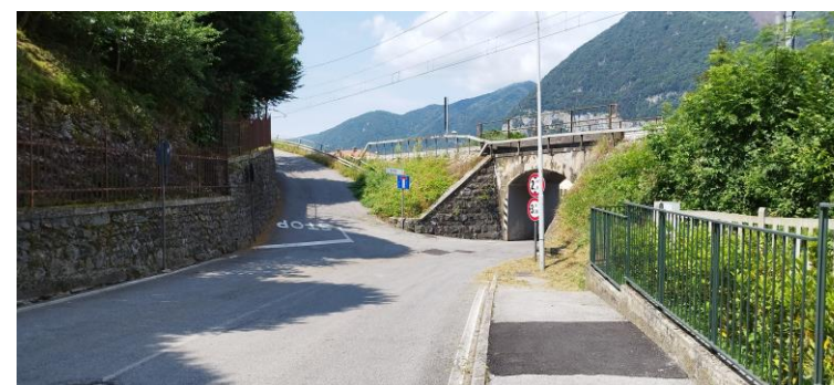
FOTO 3 Realizzazione attraversamento pedonale con segnaletica
